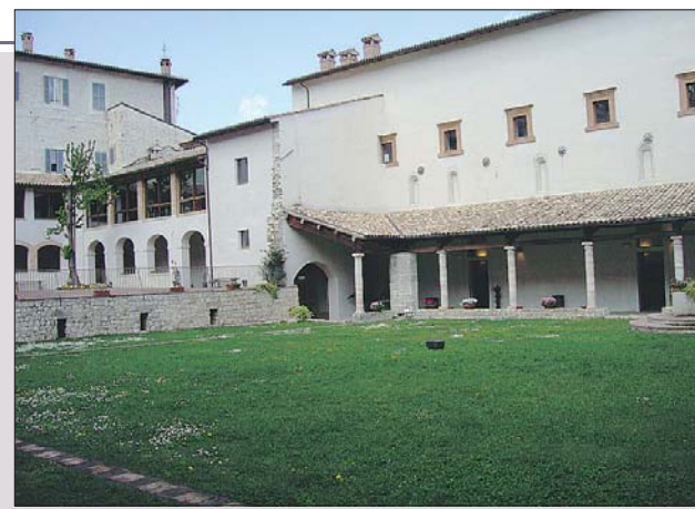
Al chiostro di San Nicolò Si parla di ricostruzione post sisma
